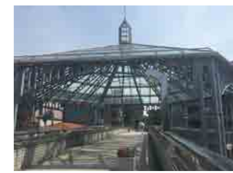
「中川駅前の歩道橋」 廣田心乃 真ん中にある多角形の屋根がとてもすてきです。ドラマの撮影にも使われています。
